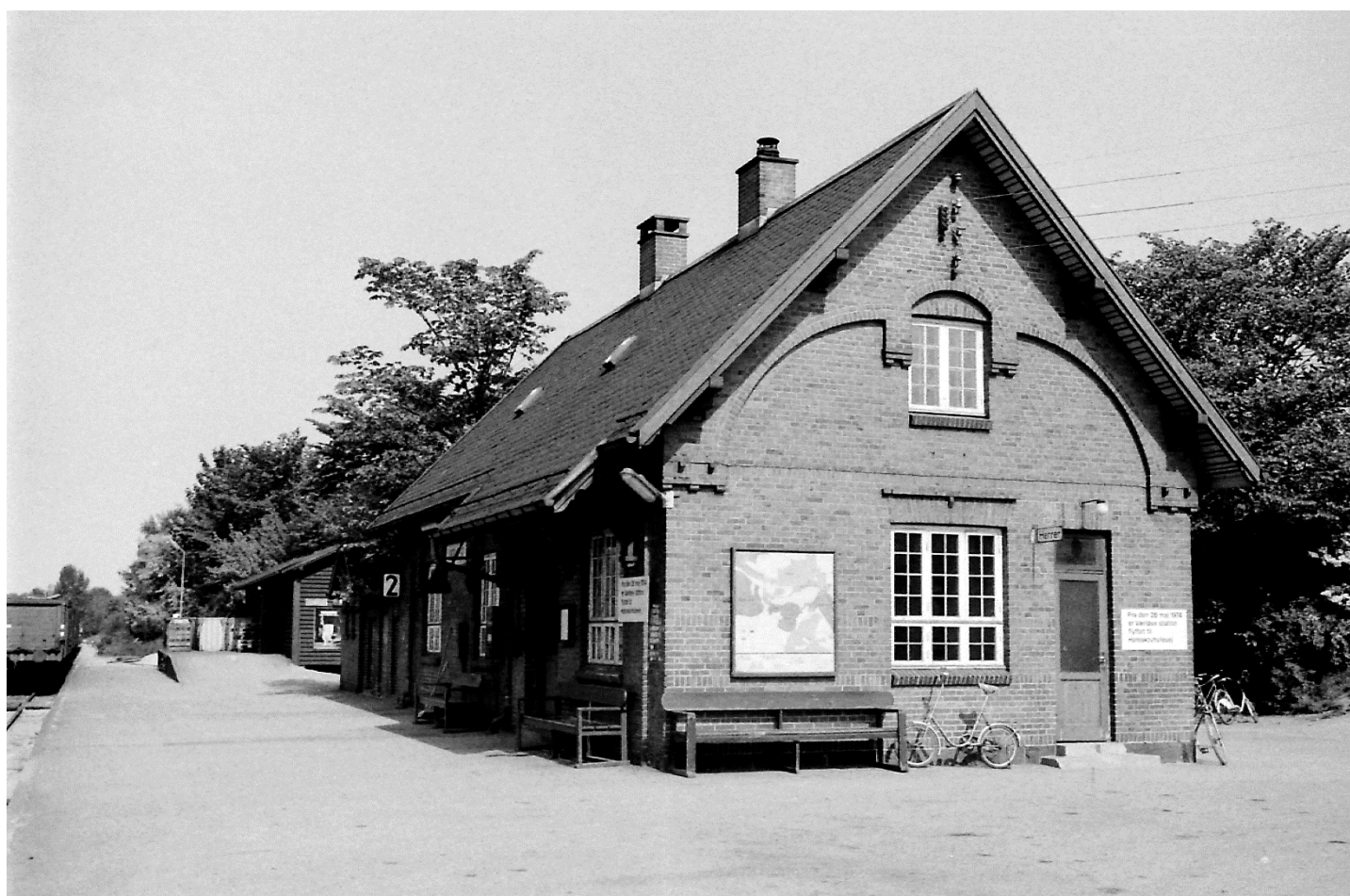
Gavl af stationsbygning set fra sydenden af perronen 24-5-1974 (M4822)
