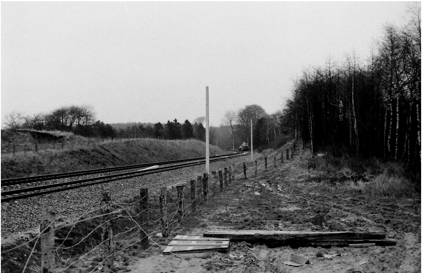
Overkørslen er væk ved Bavnegården 4-2-1975 (A6314)
